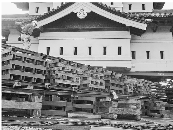
地上高3メートルでの一次曳屋（平成27年9月）
