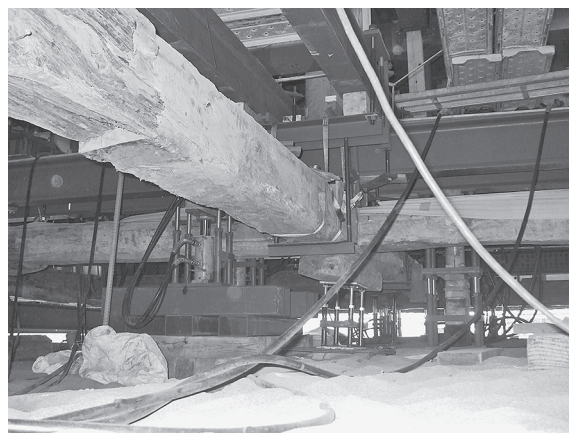
地切り（揚屋）直後の天守土台下（平成27年8月）
