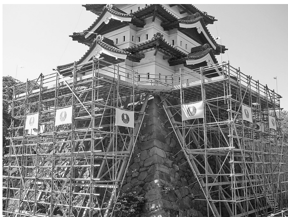
作業構台足場の普請風化粧
