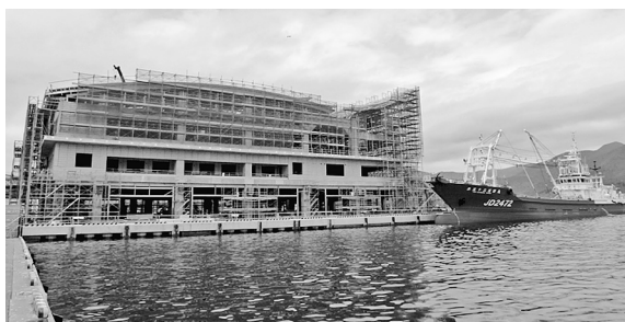
建設が進む大船渡の HACCP 対応市場と日本初の EU・HACCP 運搬船（第53石田丸）
