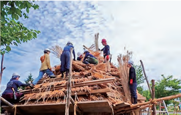
チセの屋根「草葺き屋根」作成の様子
