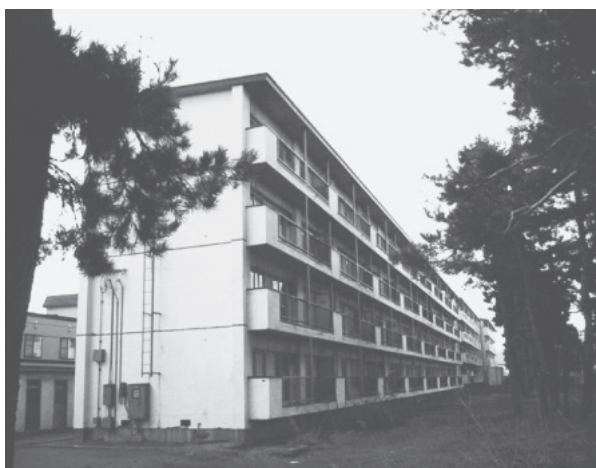
ファミリーハウスに改修前の職員公舎
