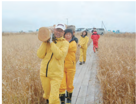
ハーゲンダッツ木道修復作業
