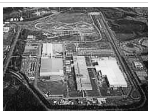
関東自動車工業㈱岩手工場 （岩手県金ヶ崎町）
