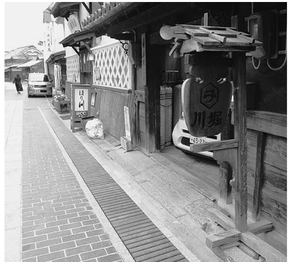
新しい素材でフタをした側溝
