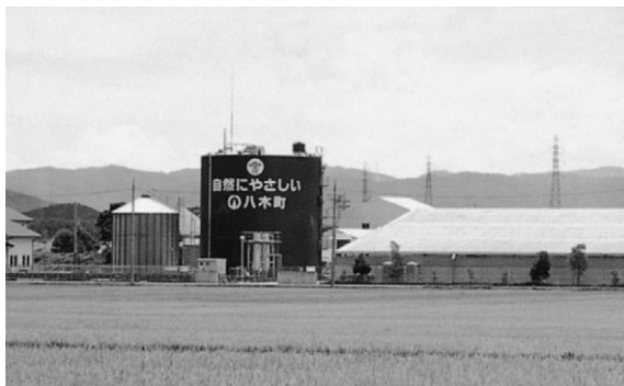
「八木バイオエコロジセンター」（10年7月稼働）
