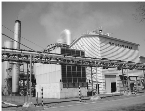
「能代木質バイオマス発電施設」(15年2月稼働)
