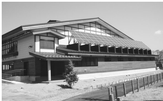
太陽光発電パネルが設置された常盤小学校
