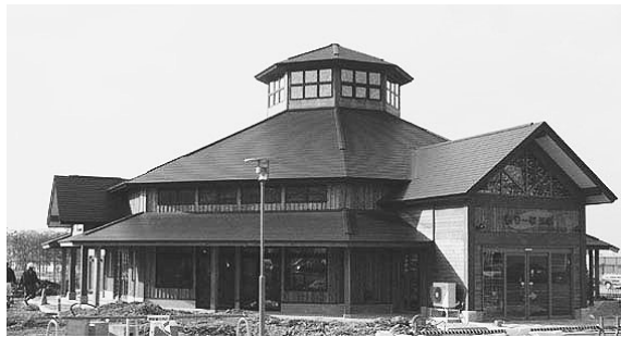
ペレットボイラーを導入した「天童市森林情報交流館」
