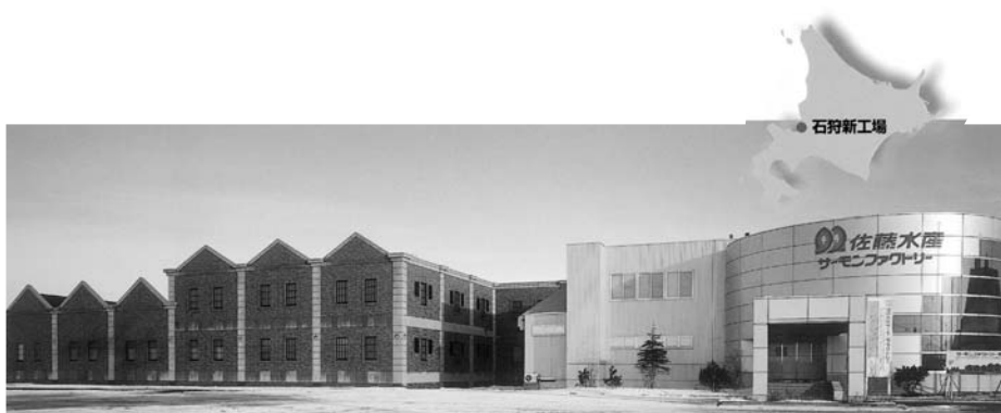
サーモンファクトリー工場（当社のパンフレットより）
