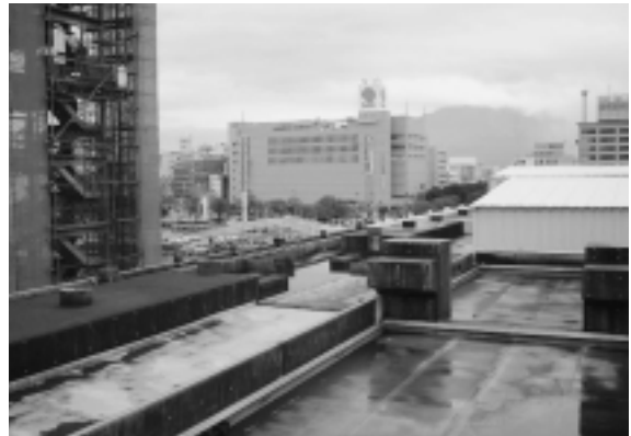
新幹線ホーム建設現場から駅前広場方面
